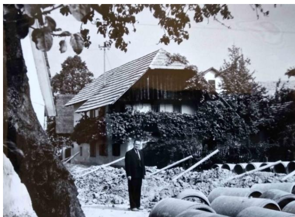
Slika 45: Albin Pavlin pred Žmajdovo hišo okoli leta 1961, v času napeljevanja kanalizacije v Stobu 40 (arhiv Alenke Pavlin).
