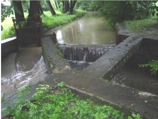
Slika 165: Razbremenilnik v Zgornjih Jaršah, na levi strani je zapornica, ki dopušča odtekanje enega m 3 vode v strugo Mlinščice, druga voda se izliva v razbremenilnik proti Kamniški Bistrici na desni, avgust 2002.
