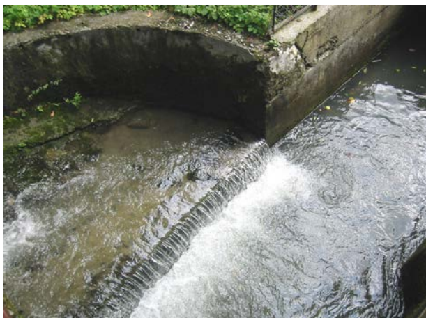
Slika 118: Voda se iz varovalnega preliva vrača v strugo Mlinščice, pri Slabičevem mlinu, avgust 2002.
