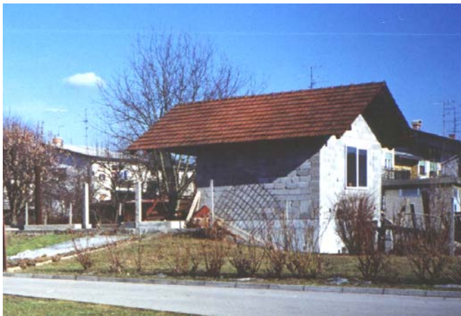
Slika 148: Dolganova elektrarna na Rodici stoji na temeljih nekdanje Hojakove žage, februar 2000.
