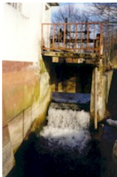
Slika 112: Dvignjena zapornica na jezui pri nekdanjem Bedenikovem mlinu, marec 2000.
