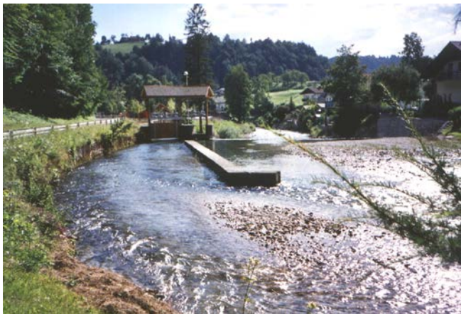
Slika 27: Jez in zapornica za Mlinščico Kalcit v Stahovici, avgust 2002.
