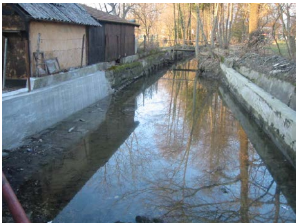
Slika 119: V času zaprte Mlinščice je bil čas za obnovo zidov pri jezu, Slabičeva elektrarna, marec 2002.
