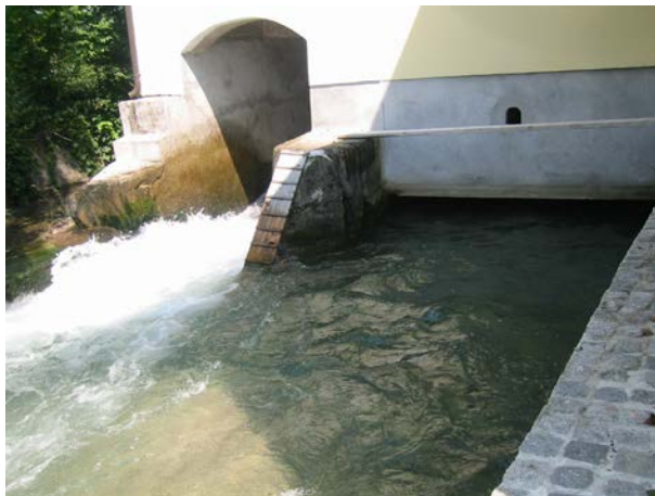
Slika 178: Pretočni kanal (levo) in prostor za turbino (desno) pri nekdanjem Kramarjevem mlinu v Preserjah, avgust 2002.
