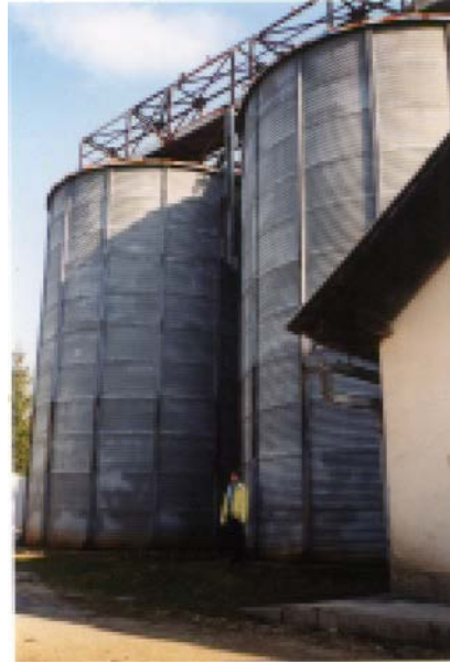
Slika 58: Za Osolinovim mlinom sta stala dva 200-tonska silosa za žito, marec 2000.
