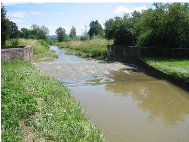
Slika 168: Razbremenilni kanal Pšate v Zgornjih Jaršah na mestu, kjer pod njim teče Mlinščica, avgust 2002.
