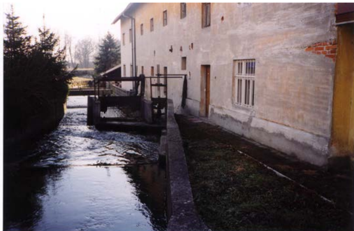
Slika 45: Pogled na Zalokarjev mlin v smeri toka Mlinščice, februar 2000.
