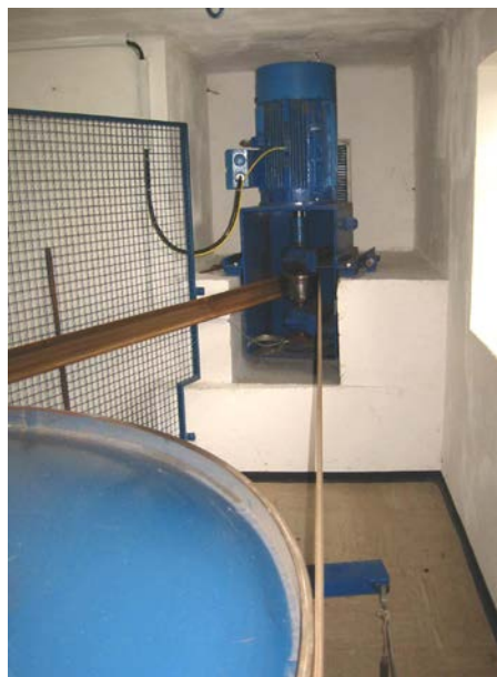
Slika 116: Generator v Slabičevi elektrarni, avgust 2002.
