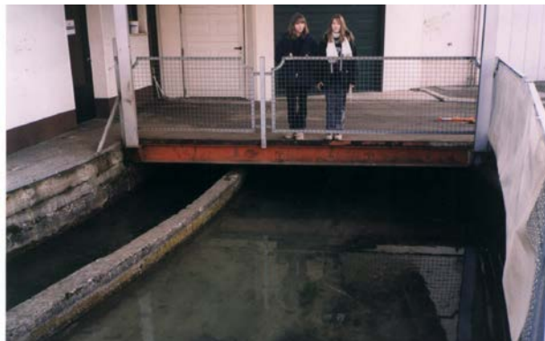
Slika 87: Struga Mlinščice izginja pod novim poslopjem, ki so ga zgradili na mestu nekdanjega Kraljevega mlina april 2000.
