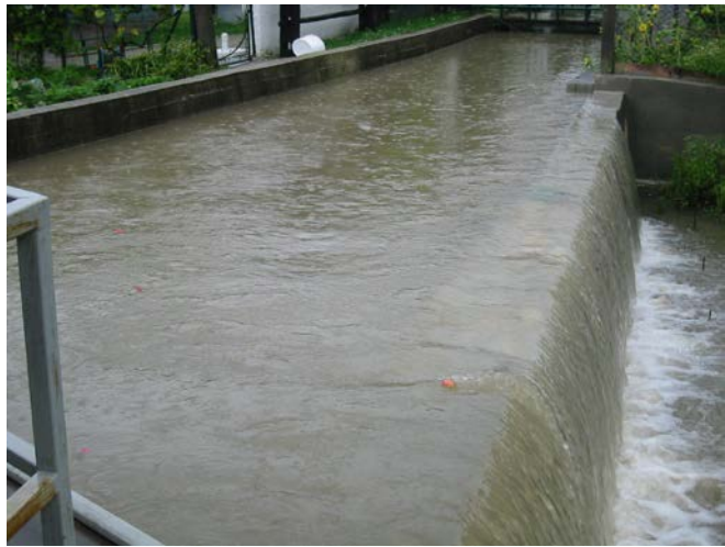
Slika 152: Če je vode preveč, odteka v razbremenilni preliv in nazaj v Mlinščico, avgust 2002.
