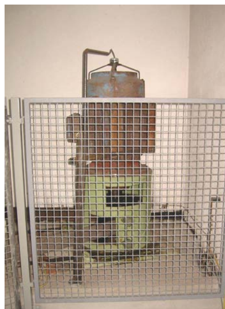
Slika 155: Generator v Dolganovi elektrarni, avgust 2002.
