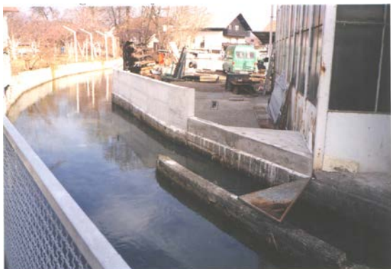
Slika 86: Pregrajena struga Mlinščice: tri četrtnine vodne moči so izrabljali za pogon mlinskih naprav v Kraljevem mlinu, eno četrtno vodne moči pa za pogon kovaških strojev v kovačiji (po domače Pri Kovaču), februar 2000.
