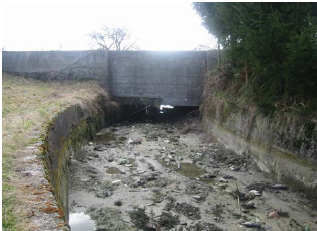
Slika 170: Rečni nanosi v strugi Mlinščice pod Zalokarjevim mlinom, nad suho strugo Mlinščice je položen razbremenilni kanal Pšate, marec 2002.
