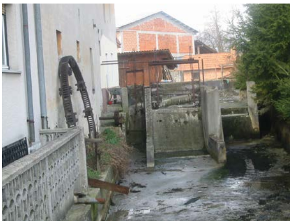
Slika 52: Ostanki zobatega kolesa, zobnik, betonske rake, rešetka in zapornica pri Zalokarjevem mlinu v času zaprtja Mlinščice, marec 2002.
