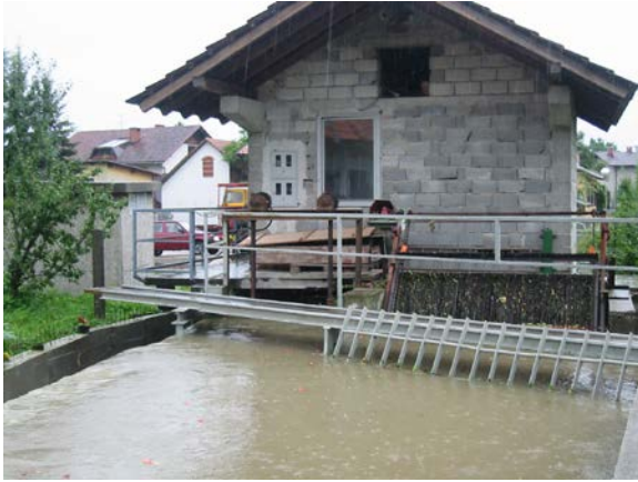
Slika 156: Dolganova elektrarna na Rodici. Grobe rešetke spredaj zaustavijo večje odpadke, ki priplavajo po Mlinščici, avgust 2002.
