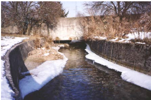
Slika 41: Betonsko korito Pšate nad starejšo Mlinščico, pogled iz smeri Srednjih Jarš proti severu, januar 2002.
