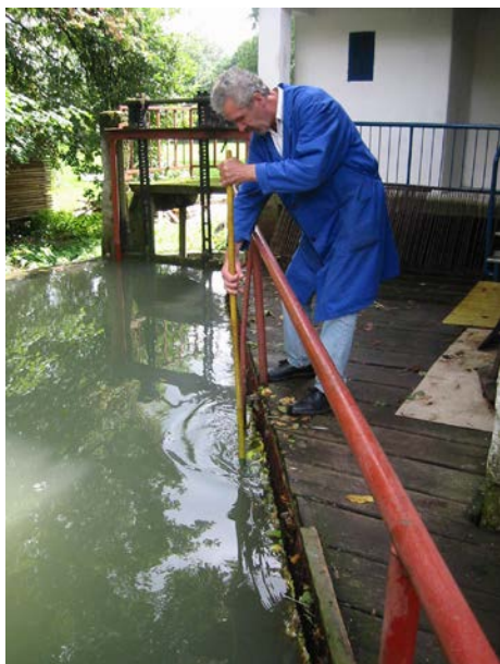
Slika 115: Miro Slabič pri vsakodnevem opravilu: čiščenju rešetak, avgust 2002.
