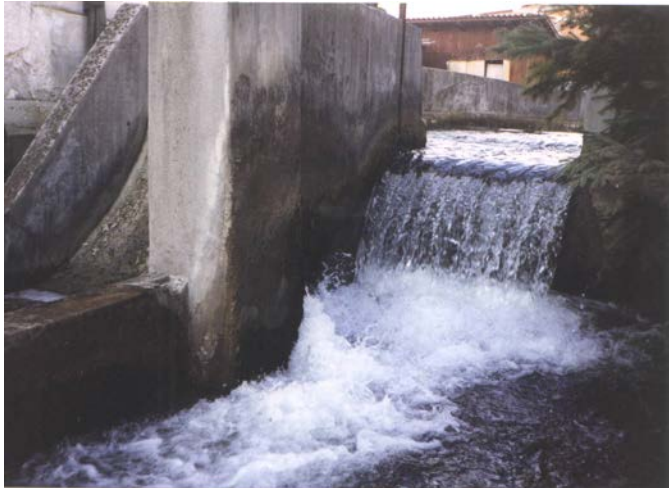
Slika 47: Opuščen vodni padec pri Zalokarjevem mlinu, levo betonska raka, v kateri je bilo veliko vodno kolo, februar 2000.
