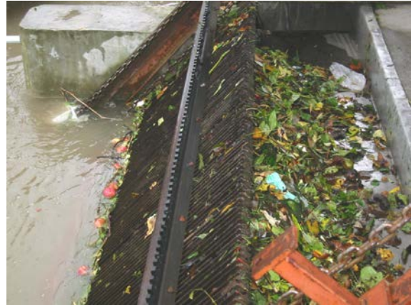
Slika 157: Fine rešetke z avtomatskim čiščenjem, na katerih se ujame veliko odpadkov, avgust 2002.
