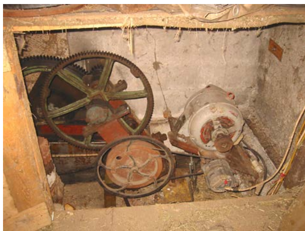
Slika 132: Prenosi in generator v Klemenčevi mali hidroelektrarni, avgust 2002.
