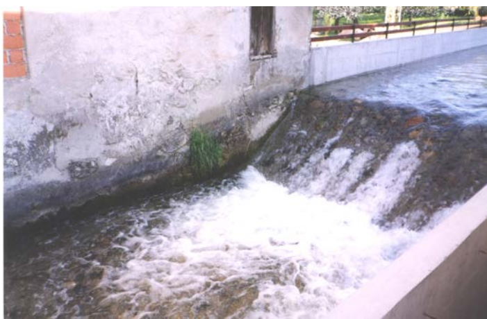
Slika 145: V stavbi nekdanjega mlina je še danes možno opaziti, kje so bila vodna kolesa nekoč povezana z mlinskimi kamni v notranjosti stavbe, april 2002.
